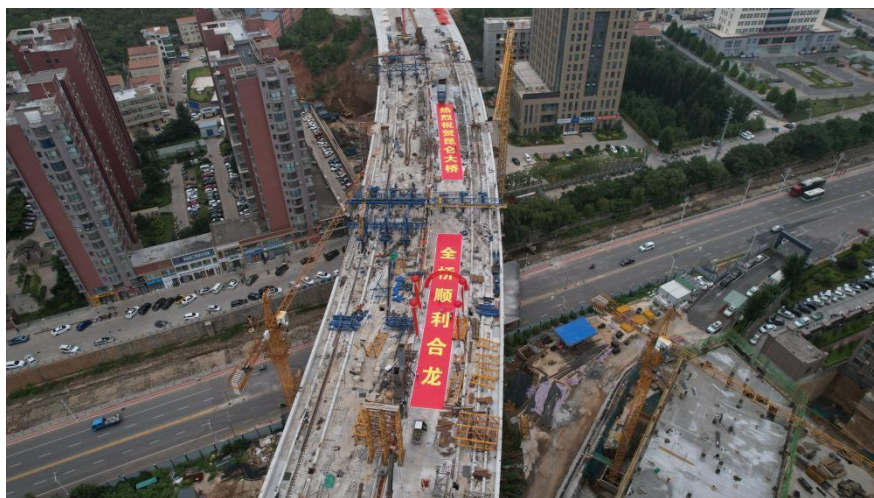
昆仑大桥合龙混凝土浇筑完成
