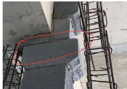
构造柱间缺墙压筋
