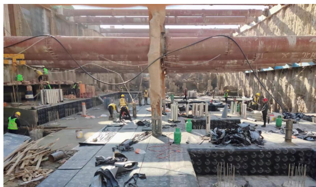
阳光揽胜基础防水作业
