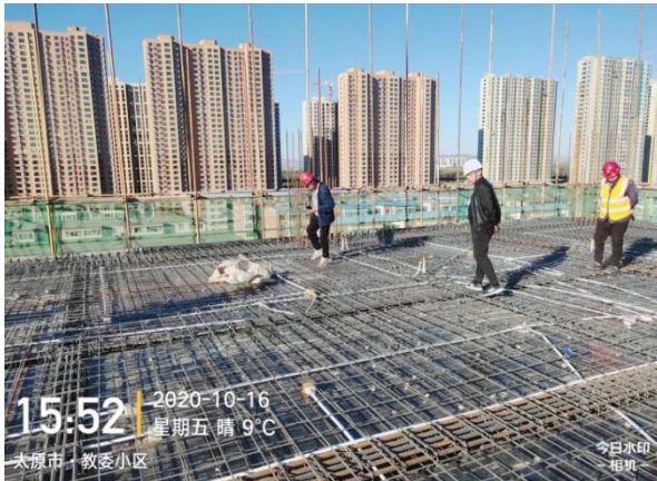
市质监站验收柴村 1 号楼 7 层顶板钢筋 (乔敏敏)
