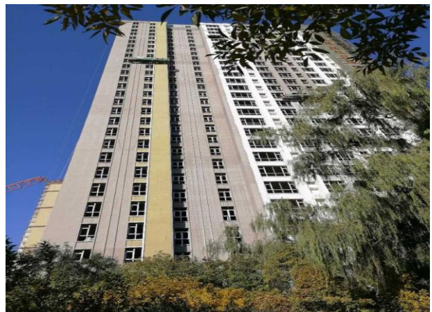
地勘院综合楼外墙施工 (李庆红)
